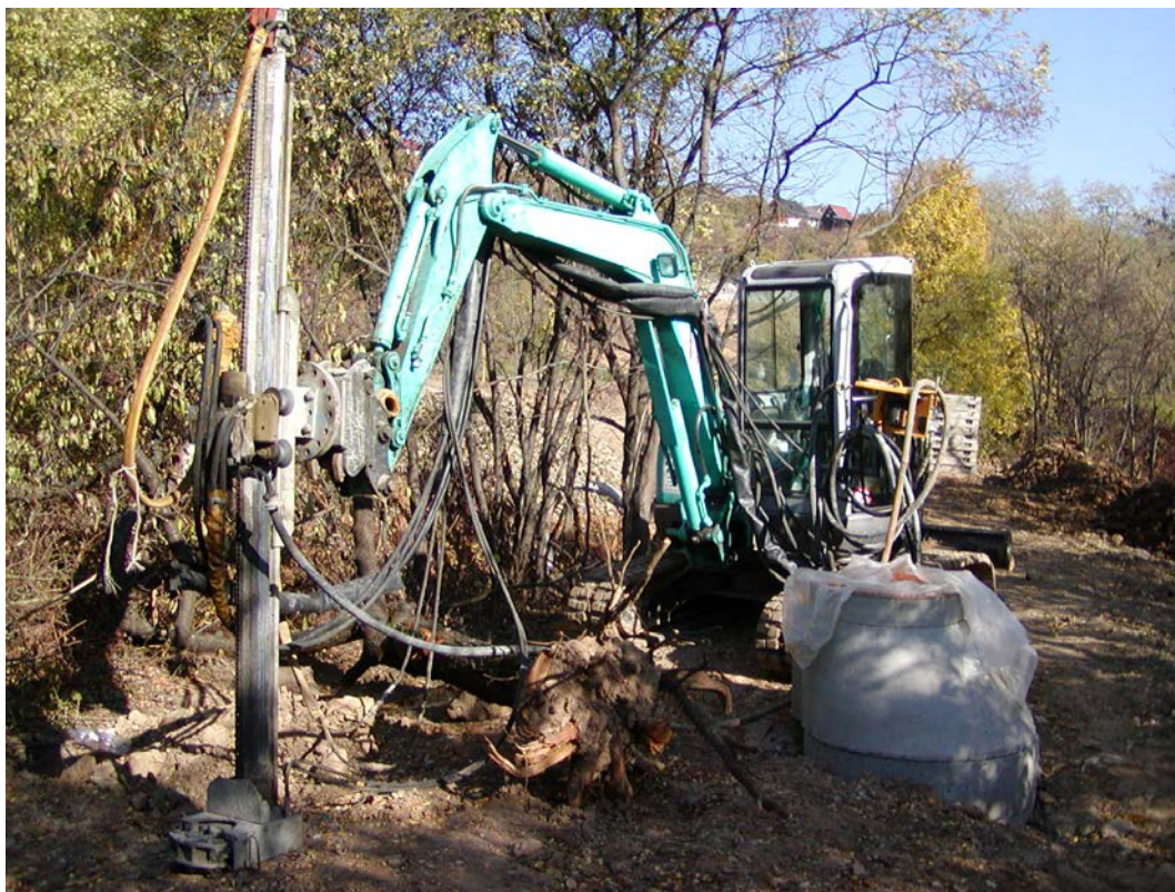
Obr.4 – Tyčová kotva IBO se ztracenou vrtací korunkou utahovací maticí a podložkou
